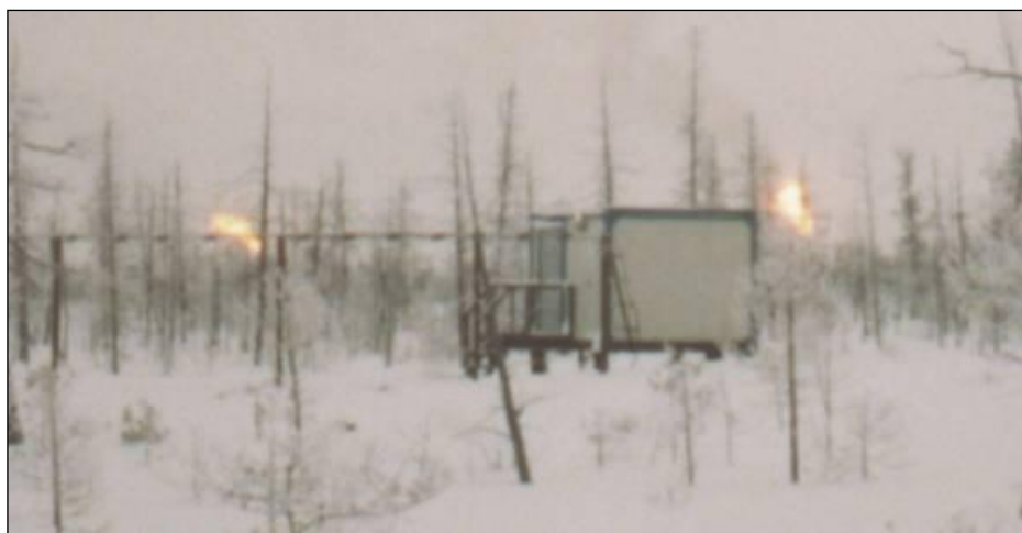
Рис. 6.3. Водозабор БКНС: вверху – общий вид БКНС; в середине – общий вид водозабора; внизу – блок-бокс.
