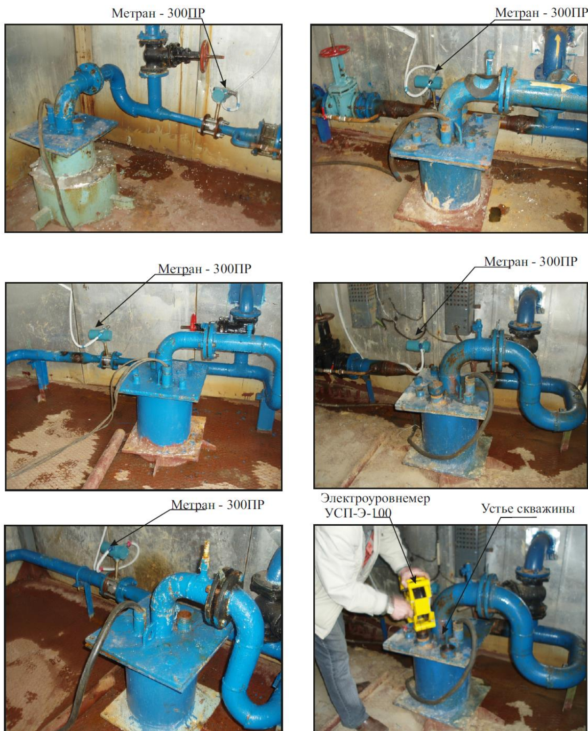
Рис. 5.5. Внутреннее оборудование боксов. По материалам отчёта [45]
